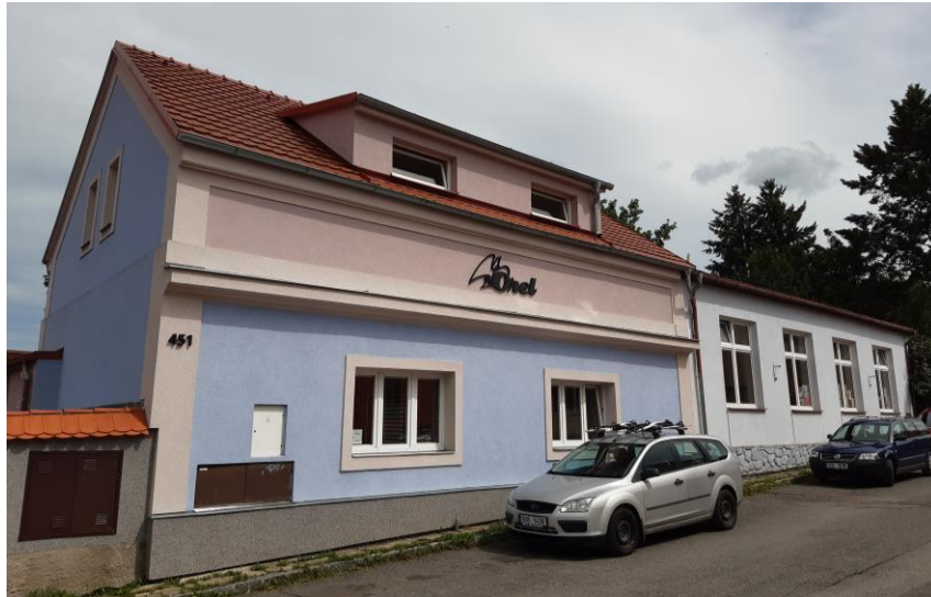
Současná budova orlovnny
